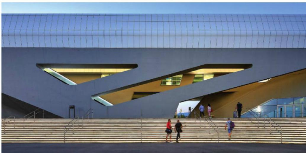
rizzato da ulteriori 6.000 mq di vetrate, sostenute da una struttura portante in calcestruzzo e acciaio. Progettato come un'estrusione di un trapezio lungo un percorso curvo lungo 450 m, l'elevato prospetto è costituito da 200 nervature in acciaio di forma diversa rivestite in Corian, con un tetto in vetro.
